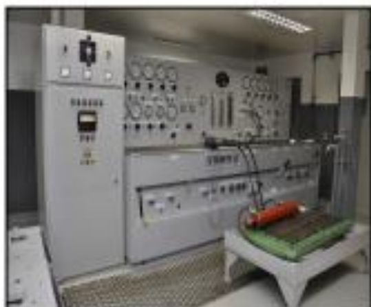
Bancada de Testes de Equipamentos Hidráulicos
